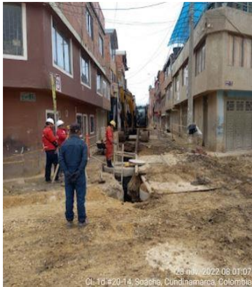
Excavacion tuberia pluvial 12" en la TV14B entre CR20 y DG43
