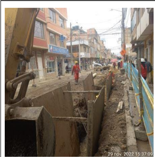
Excavacion tubería pluvial 14" en la DG42 entre TV13A y TV13
