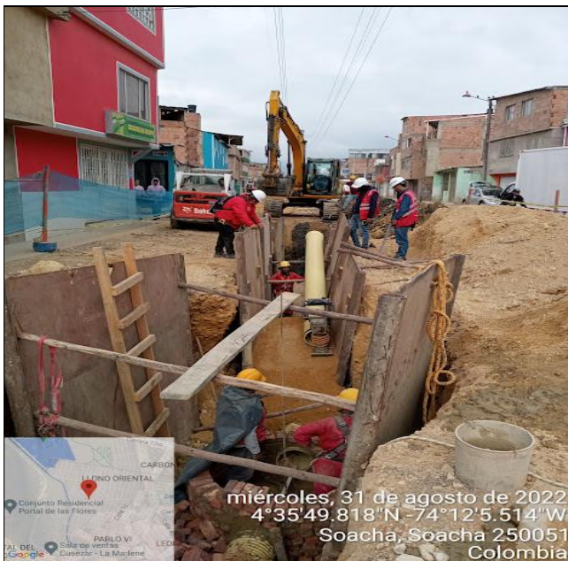
Construccion POZO SANITARIO PZ9C en la CR20 e instalacion tuberia 14\"/>
