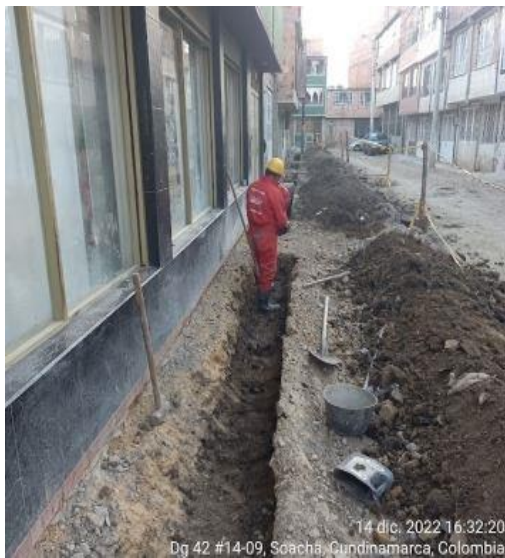
Instalacion tuberia acueducto 4" en la TV14 entre DG41C y DG42
