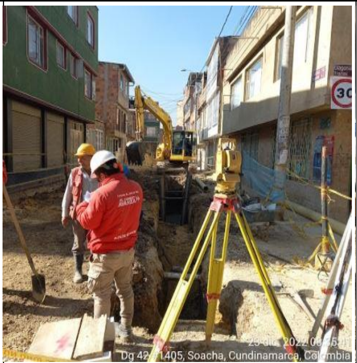
Instalacion tuberia sanitaria 8" en la TV14 entre DG41C y DG42
