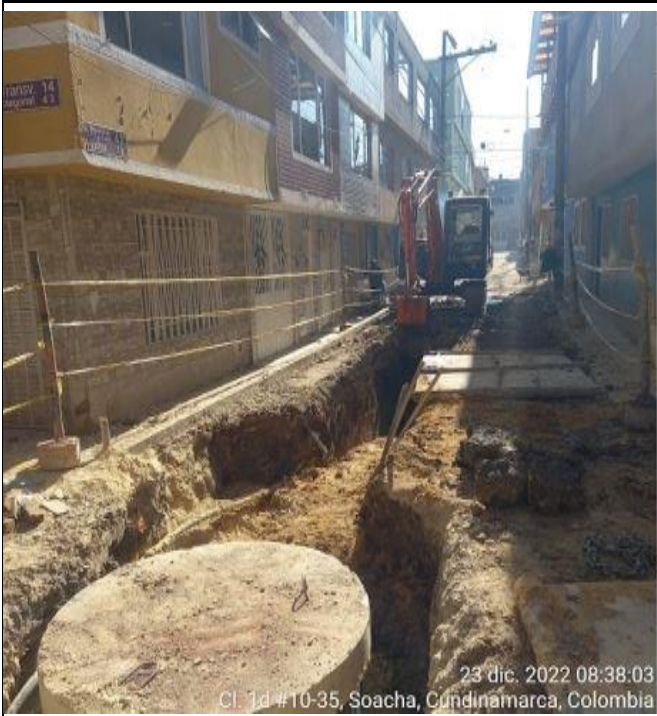
Instalacion tuberia pluvial 18" en la DG43 entre TV14 y TV13B
