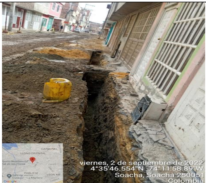
Instalacion tuberia acueducto 4\"/>
