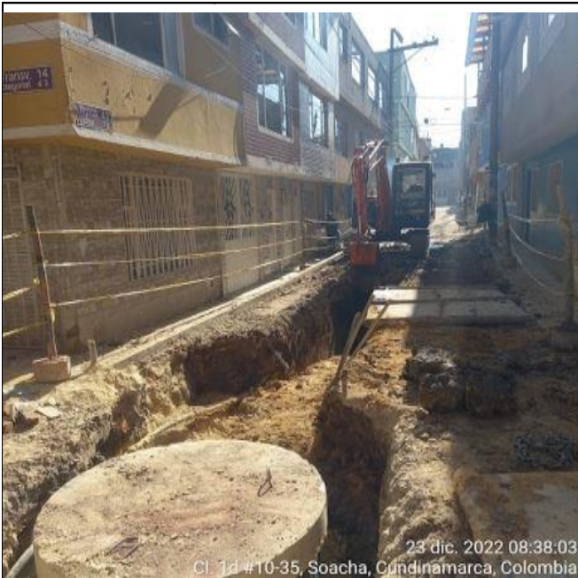
Instalacion tuberia pluvial 18" en la DG43 entre TV14 y TV13B
