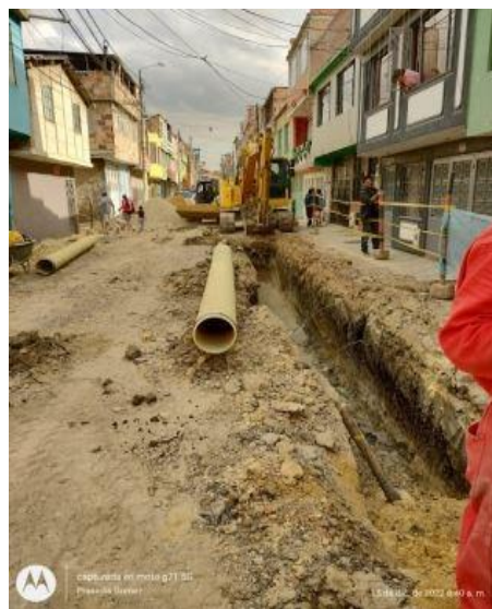
Instalacion tuberia pluvial 12" en la TV12B entre DG43 y DG42
