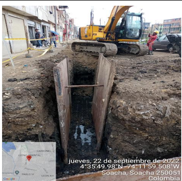
Inicio instalacion tuberia sanitaria 24\"/>
