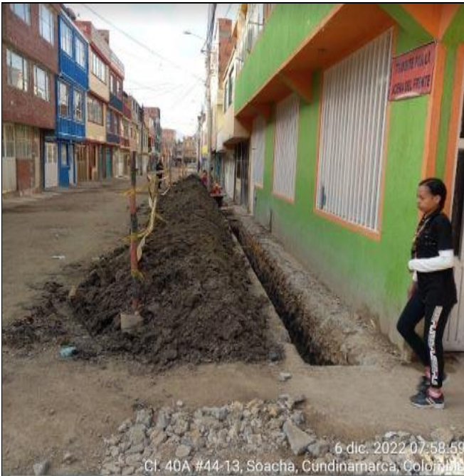
Instalacion tuberia acueducto 4" en la TV12B entre C20 y DG42
