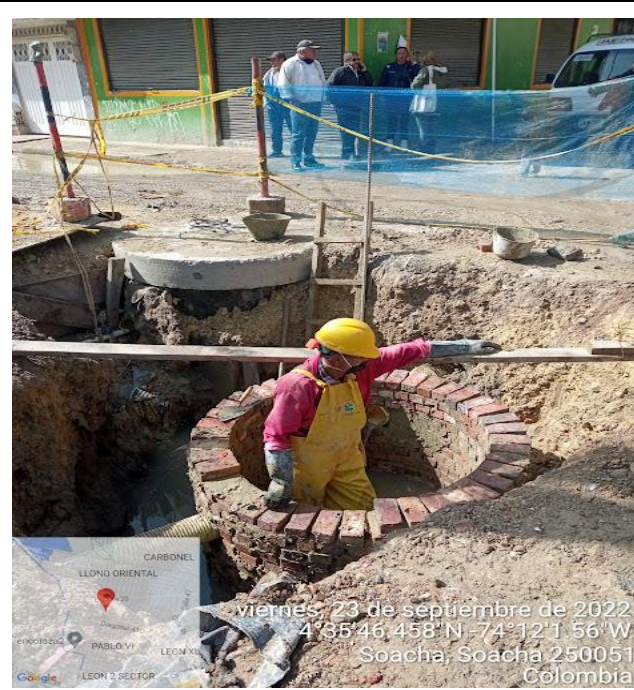
Construccion pozo sanitario DG42 con TV14
