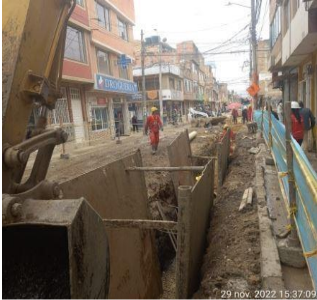
Excavacion tuberia pluvial 14" en la DG42 entre TV13AyTV13
