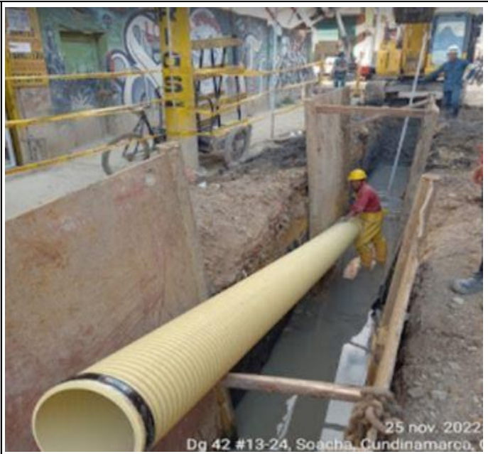
Instalacion tubería pluvial 12" en la DG42 entre TV12B y TV12A
