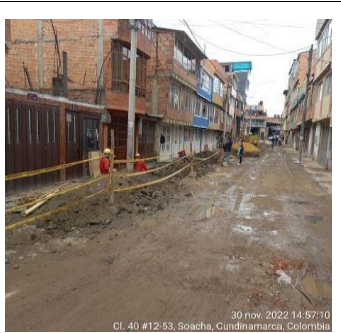
Instalacion tubería acueducto 4" en la TV12B entre C20 y DG42
