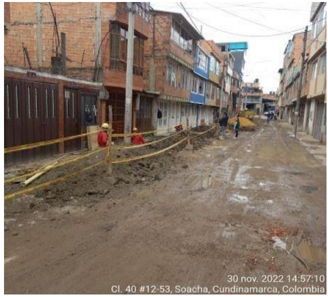
Instalacion tuberia acueducto 4" en la TV12B entre C20 y DG42
