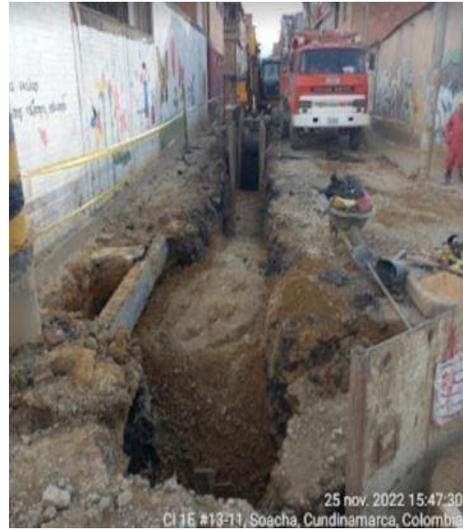
Instalacion tuberia pluvial 18" en la TV14 entre CR20 y DG44
