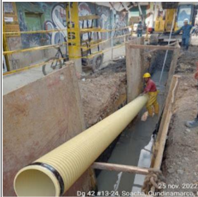
Instalacion tuberia pluvial 12" en la DG42 entre TV12B y TV12A
