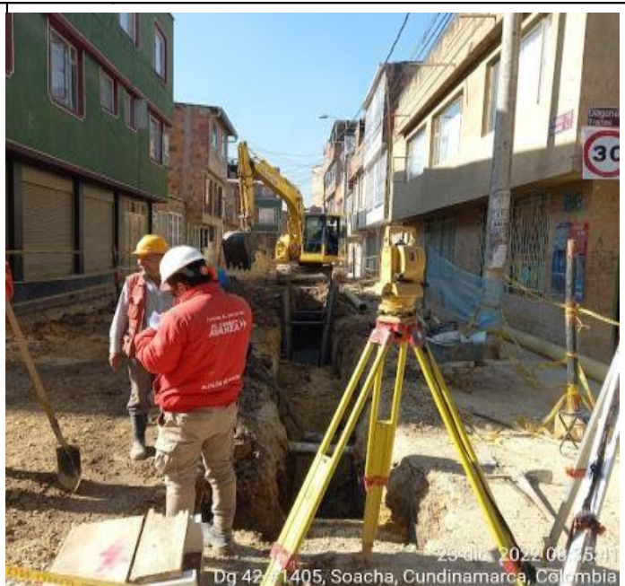
Instalacion tuberia sanitaria 8" en la TV14 entre DG41C y DG42
