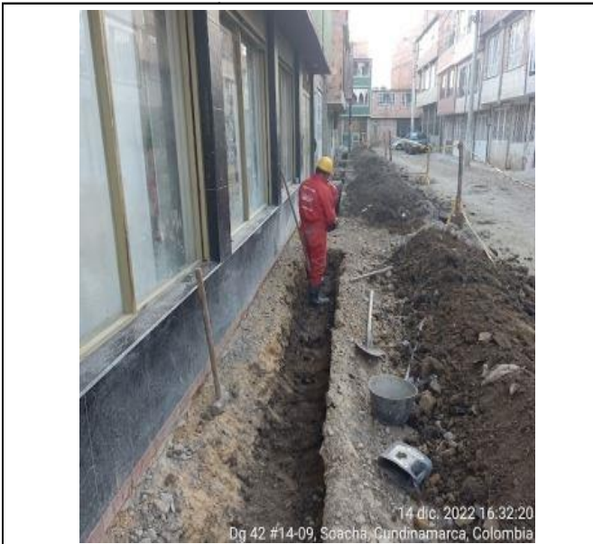
Instalacion tuberia acueducto 4" en la TV14 entre DG41C y DG42
