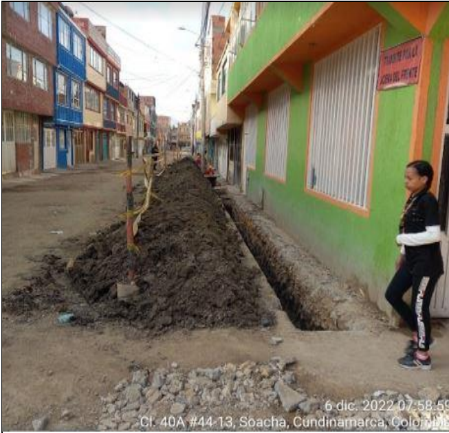
Instalacion tubería acueducto 4" en la TV12B entre C20 y DG42
