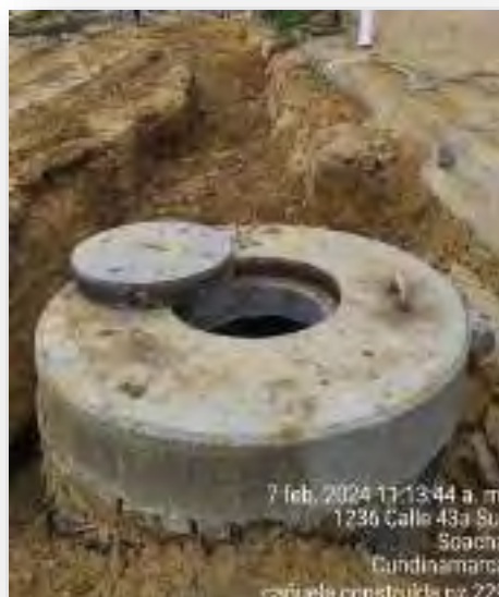
Construcción de pozos
