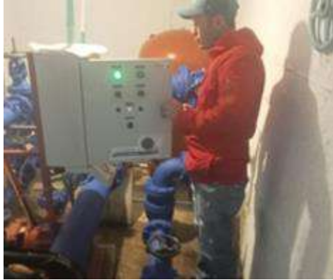
Imagen 15. Mantenimiento infraestructura acueducto.
