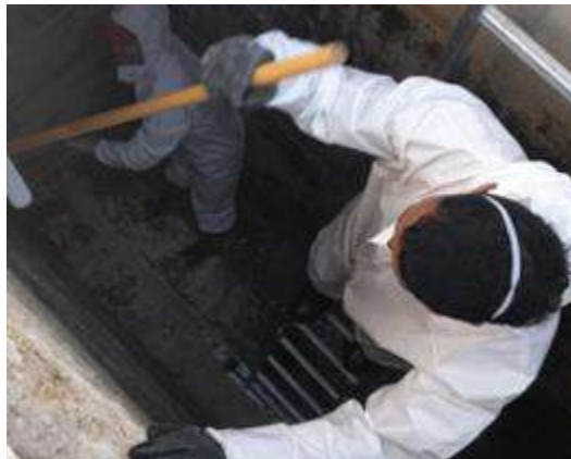
Imagen 14. Mantenimiento infraestructura acueducto.
