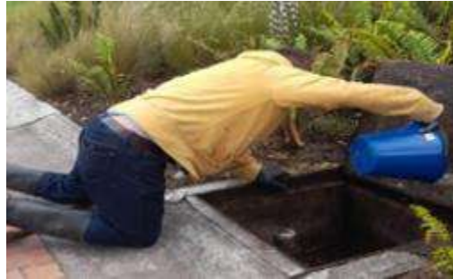
Imagen 17. Mantenimiento infraestructura acueducto.
