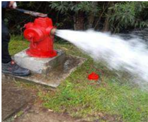
Imagen 16. Mantenimiento infraestructura acueducto.
