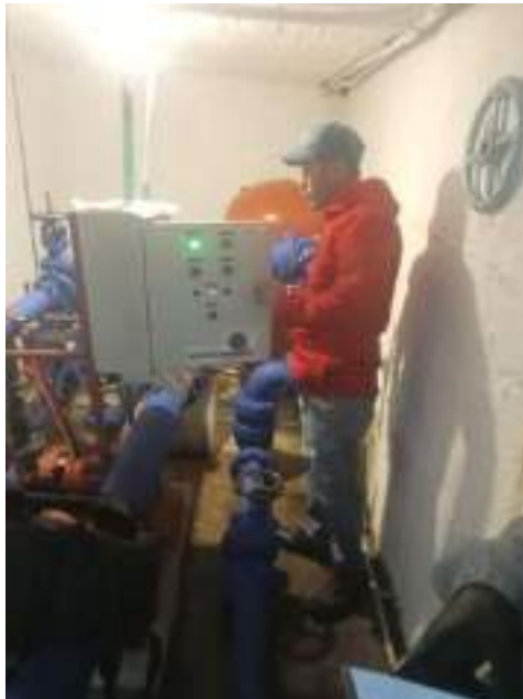
Imagen 16. Mantenimiento infraestructura acueducto.
