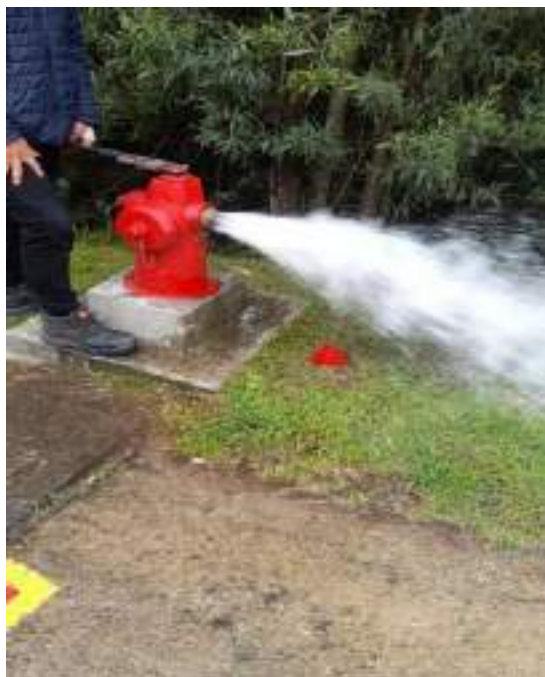
Imagen 17. Mantenimiento infraestructura acueducto.
