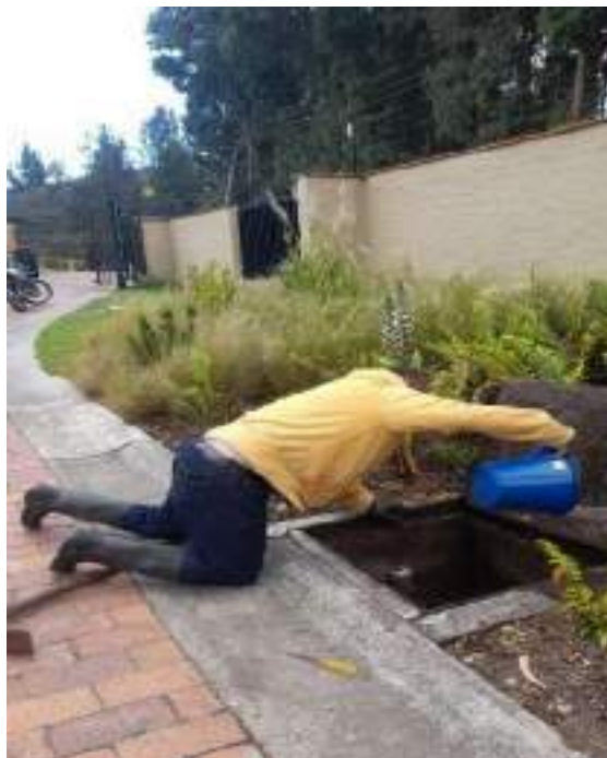
Imagen 18. Mantenimiento infraestructura acueducto.
