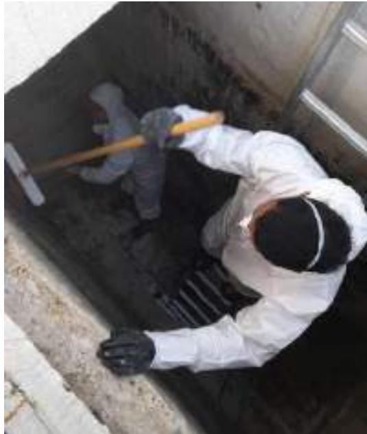
Imagen 15. Mantenimiento infraestructura acueducto.
